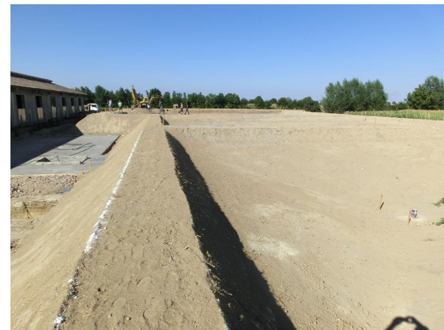
Conca ottenuta per scavo e riporto del terreno, completa di tutte le opere per il carico e scarico dei liquami, porta per ricevere il saccone
