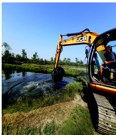
Scavatore all'opera in Valle (E. Verza)
