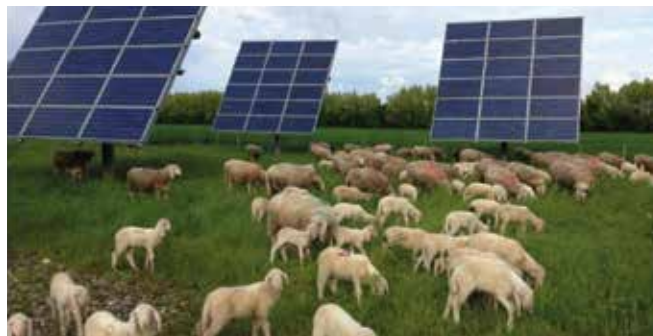
Impianto agrovoltaico realizzato in abbinamento con pascolo – Fonte: Confagricoltura
