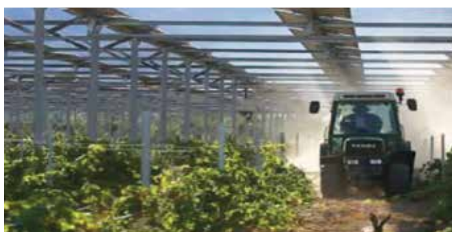
Impianto agrovoltaico realizzato in ambito vitivinicolo (© SUN'AGRI) Fonte: Report di Solar Power Europe
