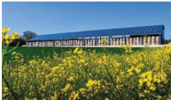
Impianto fotovoltaico su fabbricato rurale Fonte: Report di Solar Power Europe
