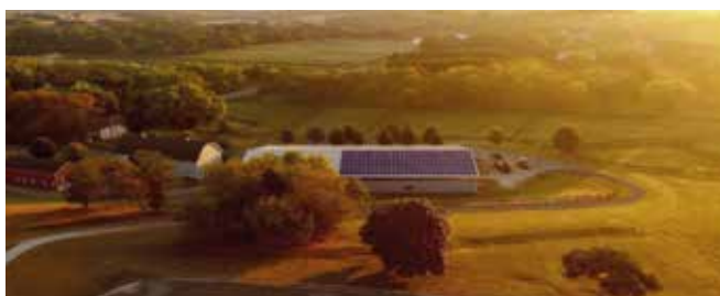
Impianto fotovoltaico su copertura di un immobile e posto nelle vicinanze di altre utenze di consumo
