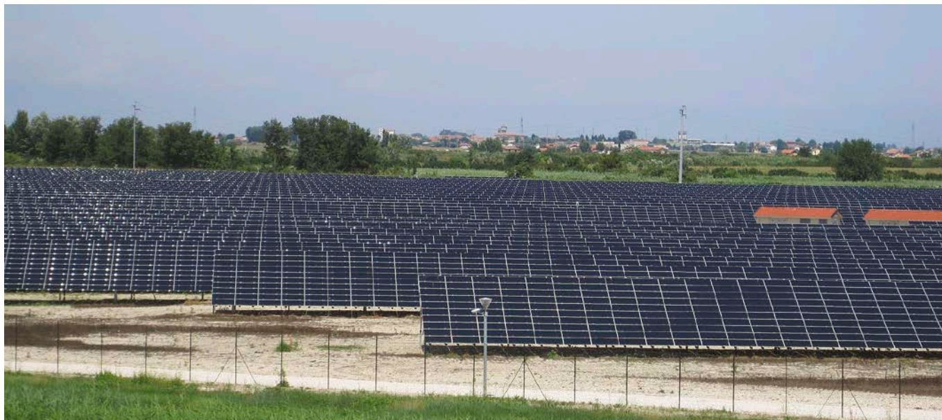
Impianto fotovoltaico nella Conca di Voltagrmana nel comune di Loreo
